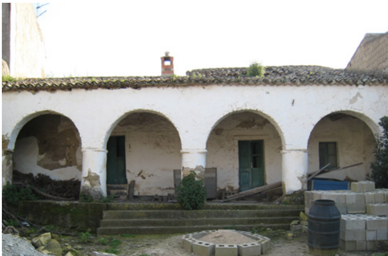
Fig. 2.19. Assolo, casa a corte con loggiato a struttura spingente con quattro archi tutto sesto su pilastri in terra cruda e pietra.
