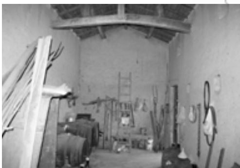
un rustico della corte, copertura con "cuaddu"
