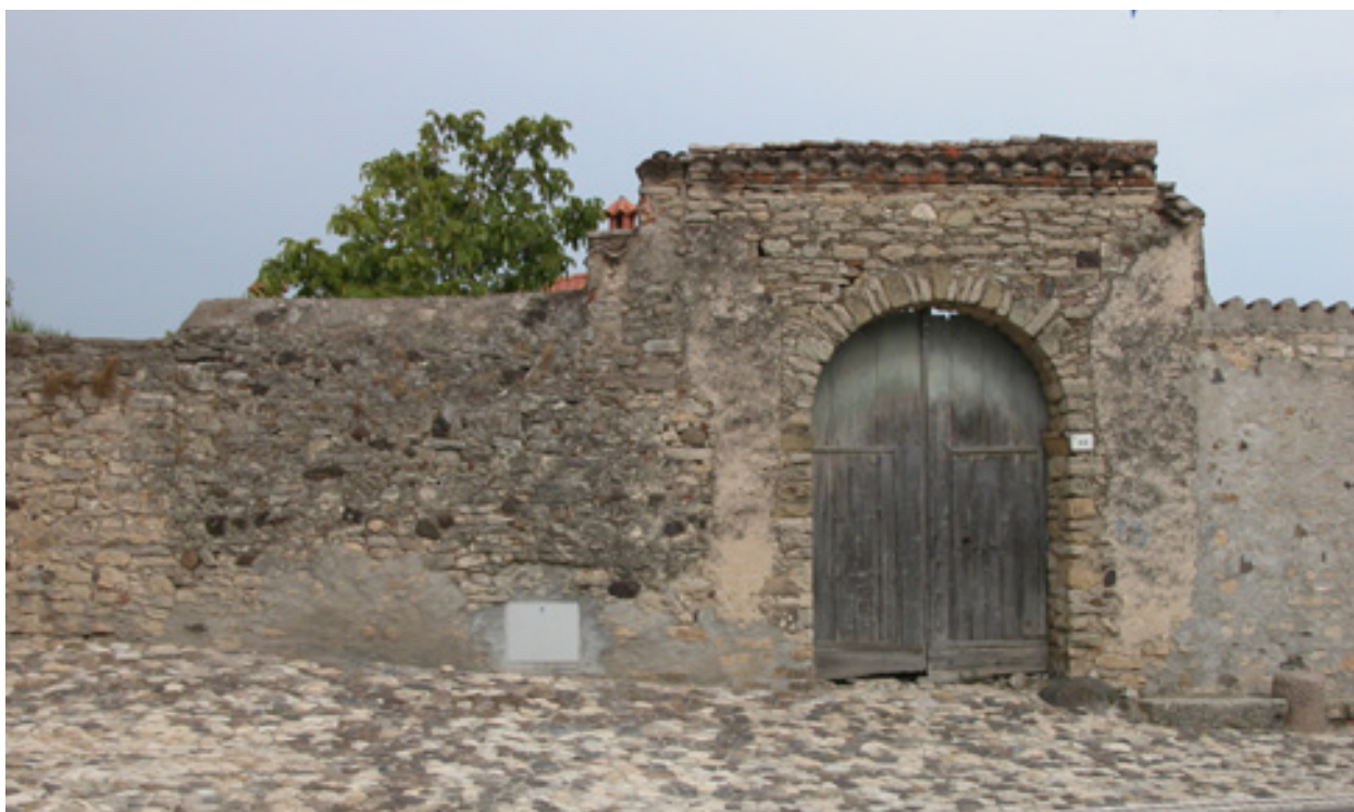
Fig. 2.37. Masullas, portale con stipiti e arco in conci sbazzati di marna.
