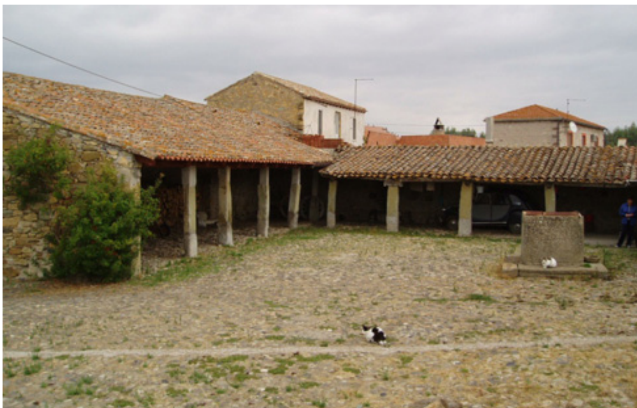
Fig. 2.41. Ales, grandi loggiati rustici architravati con ritmi monolitici. Pozzo in posizione centrale. Fig. 2.42. Simala, grande casa a corte con loggiato a cinque arcate inglobato nel corpo di fabbrica.
