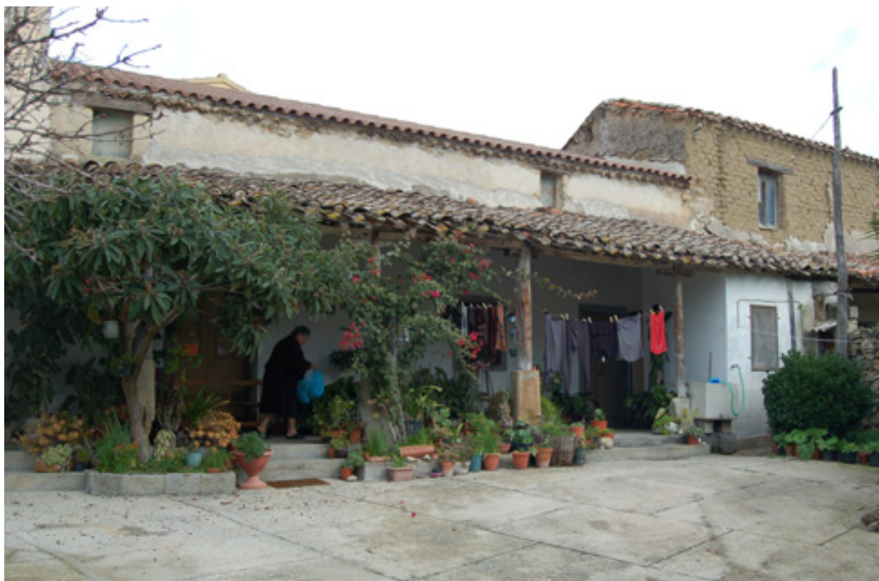
Fig. 2.17 Gonnosstramatza, casa a corte con loggiato a struttura architravata con riitti e mensole lignei.
