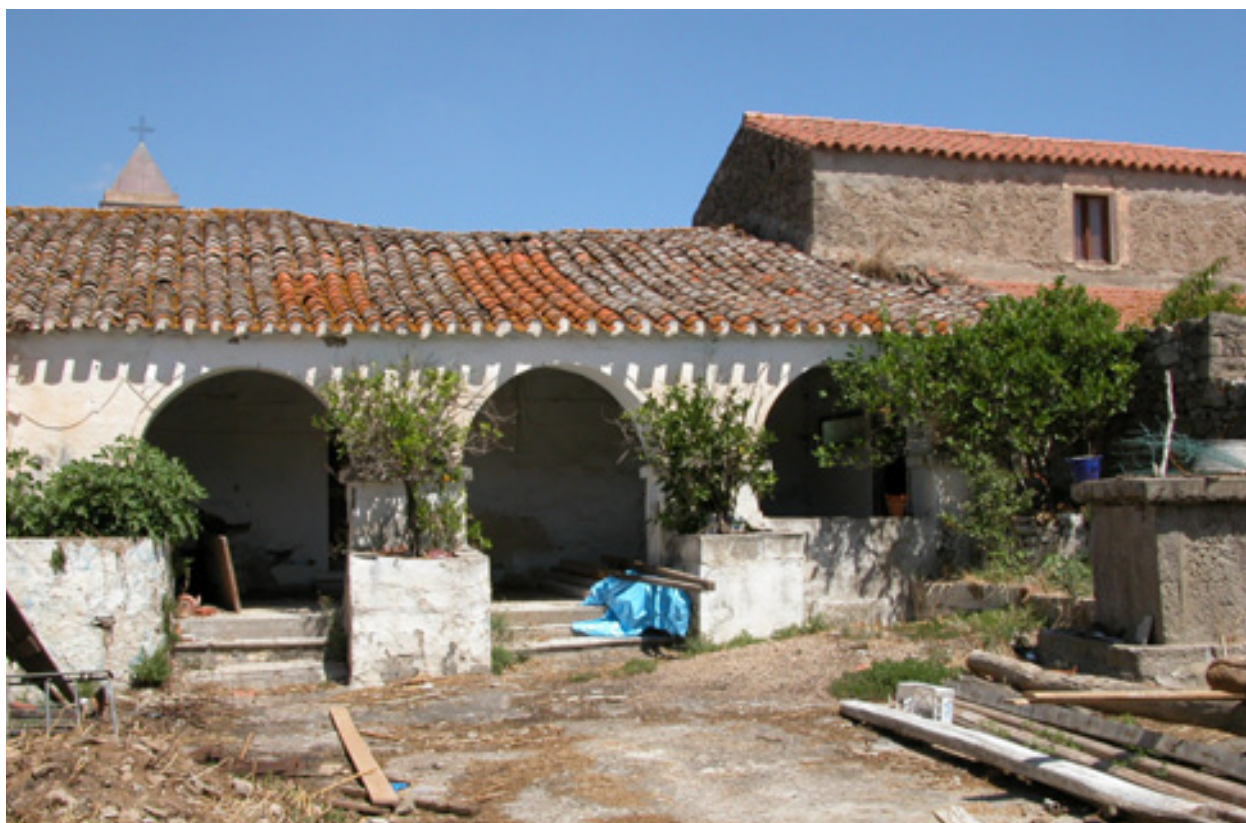
Fig. 2.18. Villa Sant'Antonio, casa con loggiato a struttura spingente costituito da tre archi a tutto sesto.
