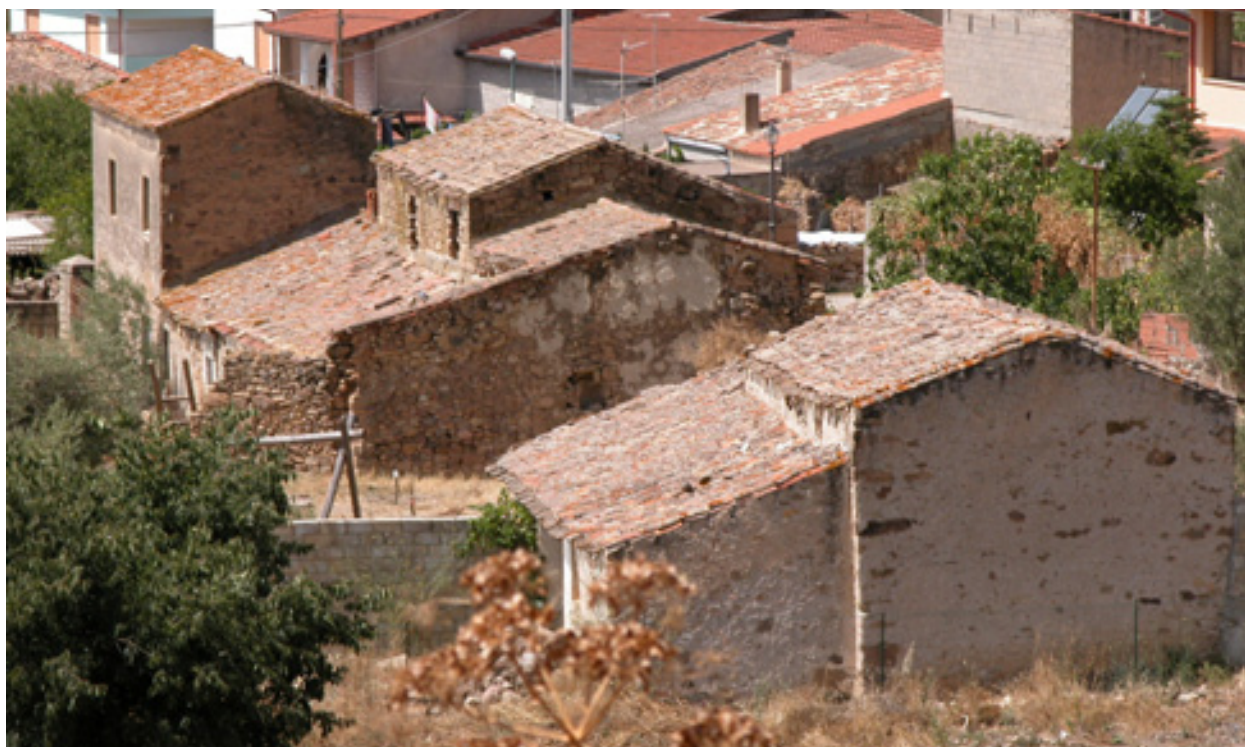
Fig. 2.75. Nureci, aggregazione di cellule edilizie per giustapposizione e sovrapposizione con sviluppi in tempi successivi.
