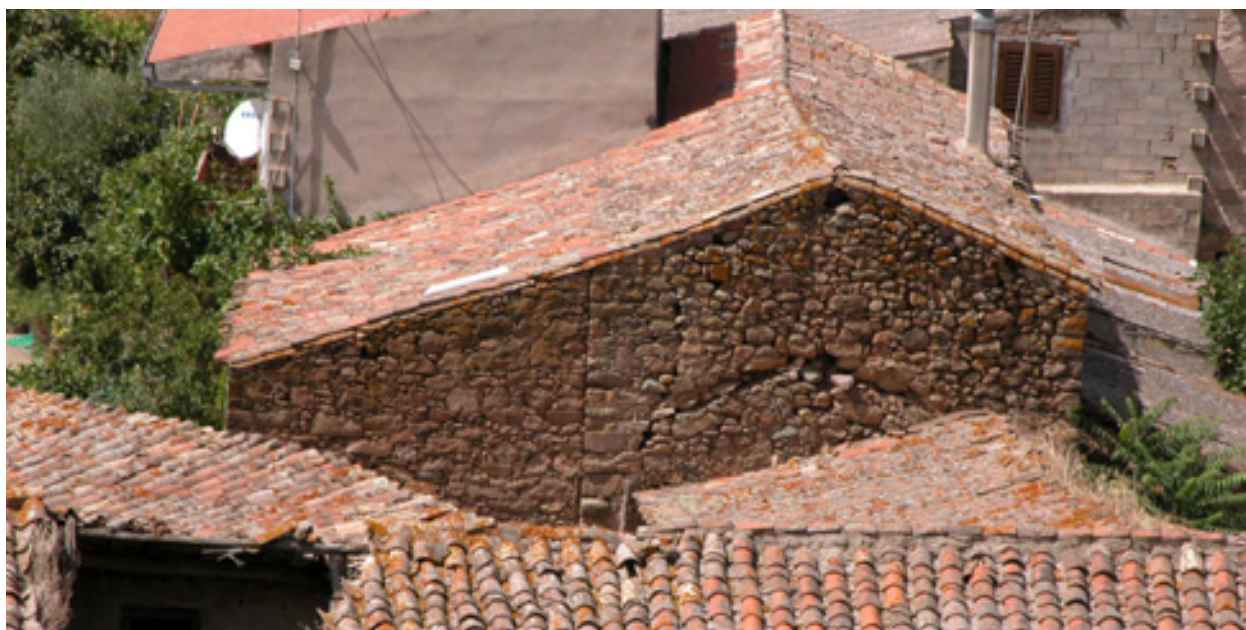
Fig. 2.77. Nureci, aggregazione di cellule edilizie per giustapposizione e sovrapposizione con sviluppi in tempi successivi.
