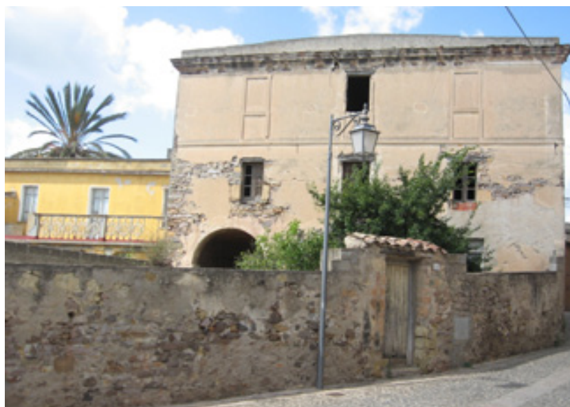
Fig. 2.71. Sardara, palazzetto con corte doppia e ingresso carrabile mediante portale ad arco e pedonale mediante piccolo portale architravato.
