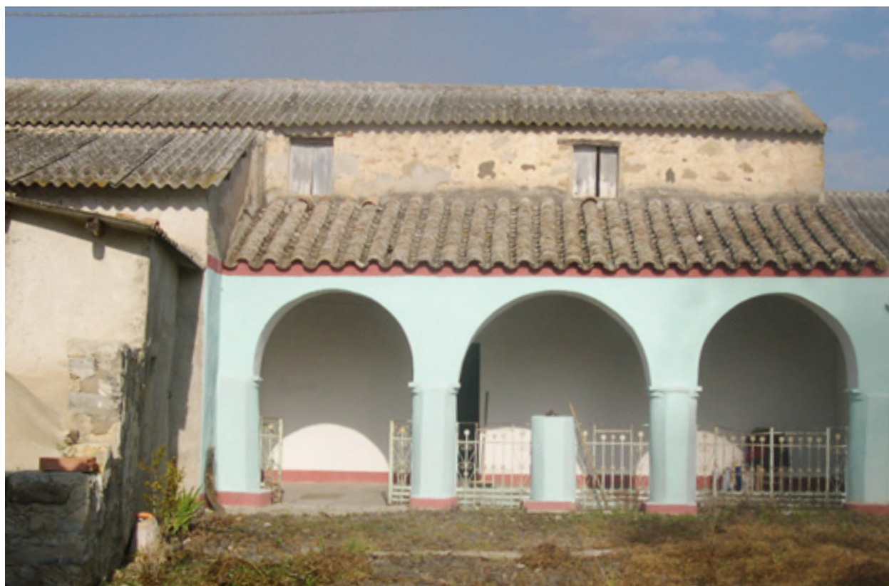
Fig. 2.20. Lunamatrona, casa con loggiato a struttura spingente costituito da tre archi a tutto sesto.
