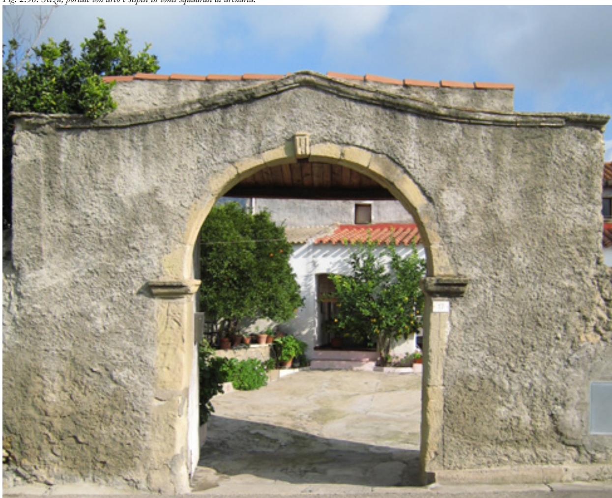
Fig. 2.38. Setzu, portale con arco e stipiti in conci squadri di arenaria.
