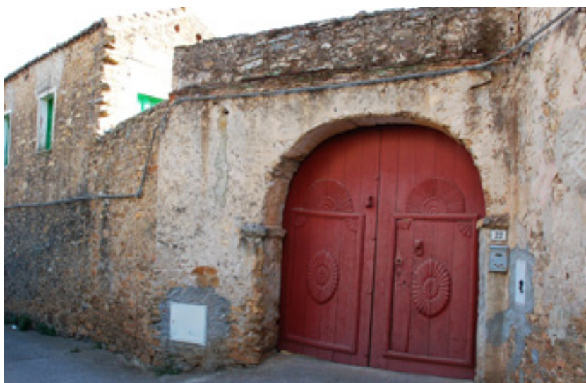
Fig. 2.62. Armungia, portale d'ingresso con arco policentrico in scisto
