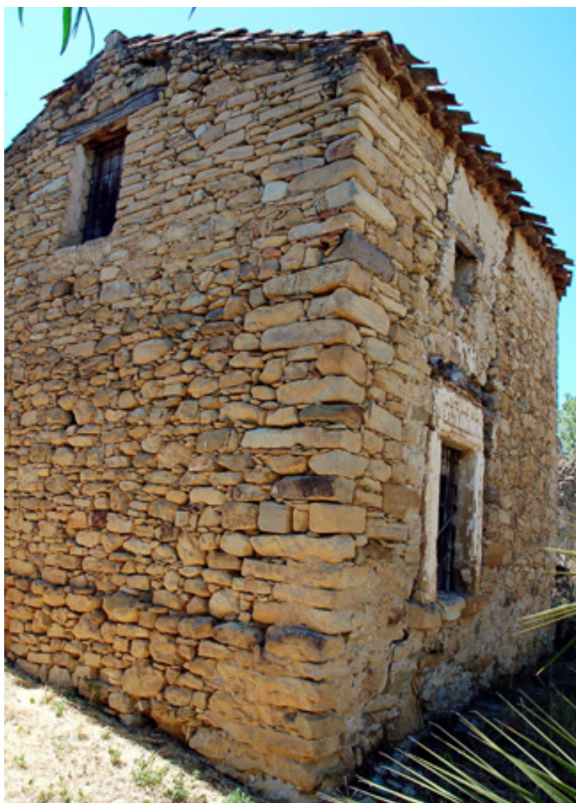
Fig. 2.77. Nureci, aggregazione di cellule edilizie per giustapposizione e sovrapposizione con sviluppi in tempi successivi.
